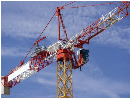
Didascalia: Gru a torre - vista d'insieme del cantiere
